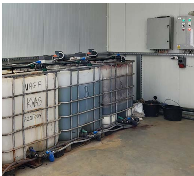
Fot. 3. Układ fertygacyjny z 3 zbiornikami do przygotowania pożywek
