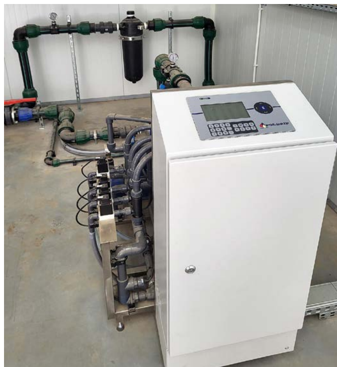
Fot. 4. Komputer nawozowy pozwala precyzyjnie sterować parametrami pożywki i częstotliwością jej podawania
