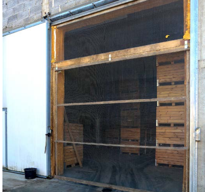
Fot. 4. Brama ze stalową ażurową siatką chroni przed dostępem gryzoni do wnętrza przechowalni
